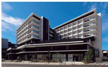
あちてらす倉敷 (岡山県倉敷市)
