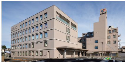
寺田病院新病棟(三重県名張市)
